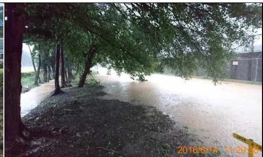
圖2 H幹線3孔箱涵上游水位抬高已溢淹至土堤及邊溝(11:20)
