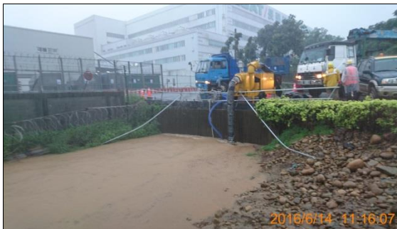
圖1 H幹線3孔箱涵上面設有抽水機，仍無法正常宣洩，逐漸上游迴壅(11:16)
