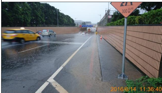
圖5 H幹線水流溢出沿車道下坡流入航站南路地下道(11:36)
