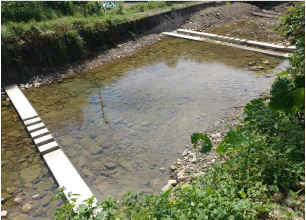
照片13 缺口式固床工可讓細顆粒土沙沖至下游補充沙源
