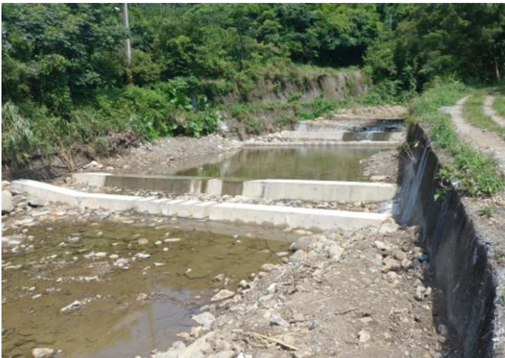
照片12 既有固床工將土沙保留於河道中
