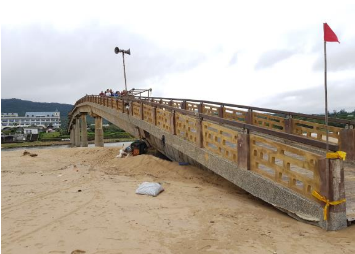
照片7 內河大橋現況照片（本院履勘攝）
