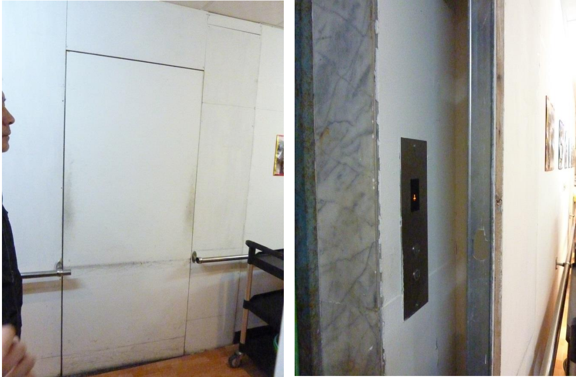
照片1 昇降設備以裝修材料封閉情形
