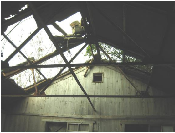
「清涼彈藥庫」部分屋頂
