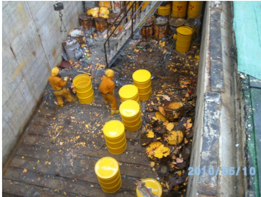
圖4 貯存溝內第四類桶 19 固化體收集裝桶作業
