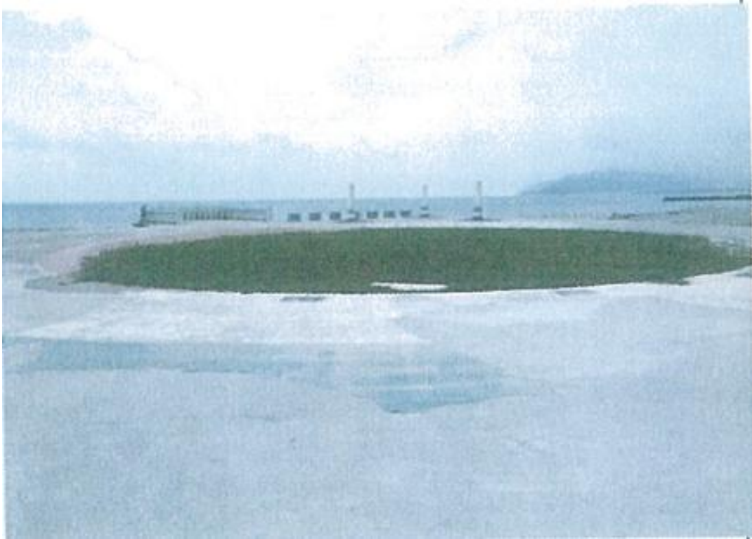
照片 5、北濱海岸舊漁村休閒設施完工後尚無法補辦建築執照之閒置現況
