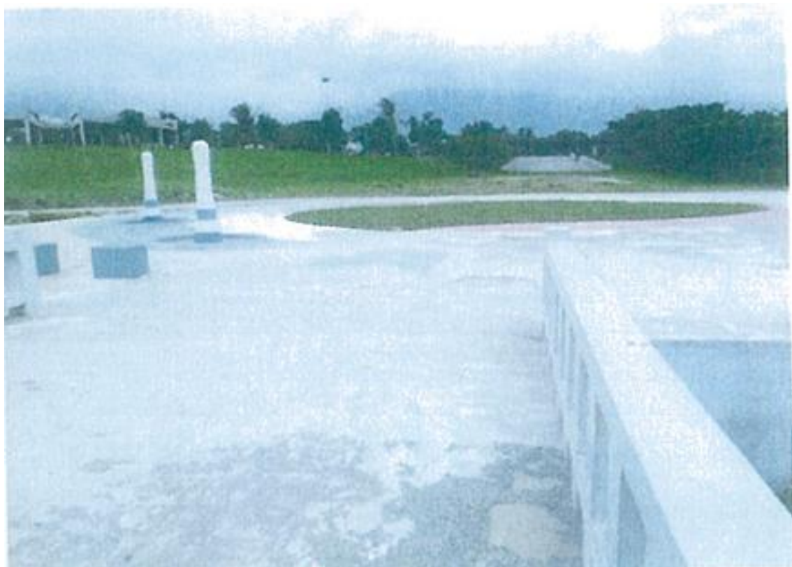
照片 6、北濱海岸舊漁村休閒設施完工後尚無法補辦建築執照之閒置現況
