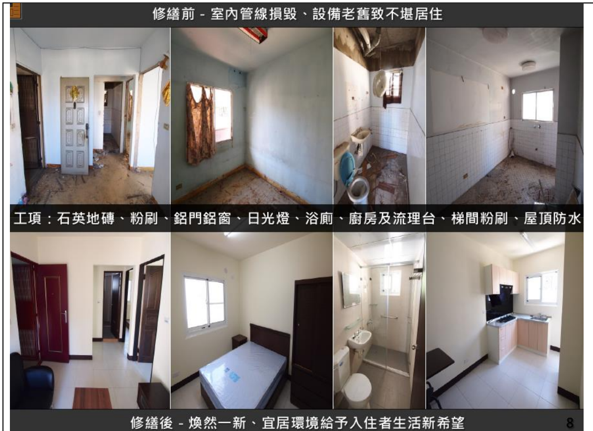
圖13、鳳山共合宅修繕前後比較情形
